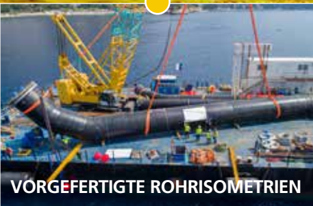
LANDSEITIGE VORBEREITUNG DES ROHRSTRANGES
