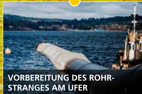
INSTALLATION LANGER ROHRSTRÄNGE
