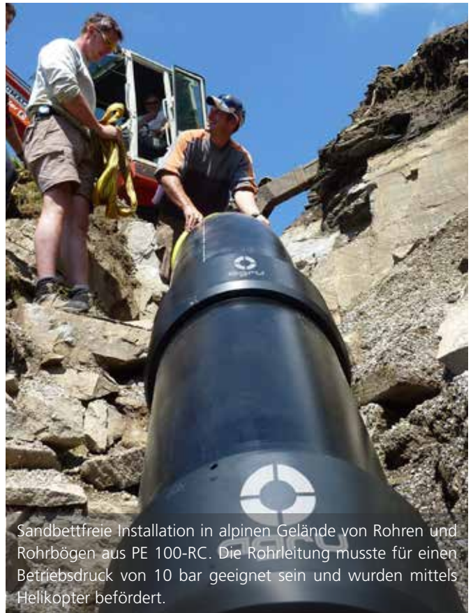
AGRU Kunststofftechnik lieferte mehrere hundert Meter PE 100-RC Rohre in Außendurchmessern zwischen d_a 560 mm und d_a 710 mm für eine neue Fernkältezentrale in Wien.
